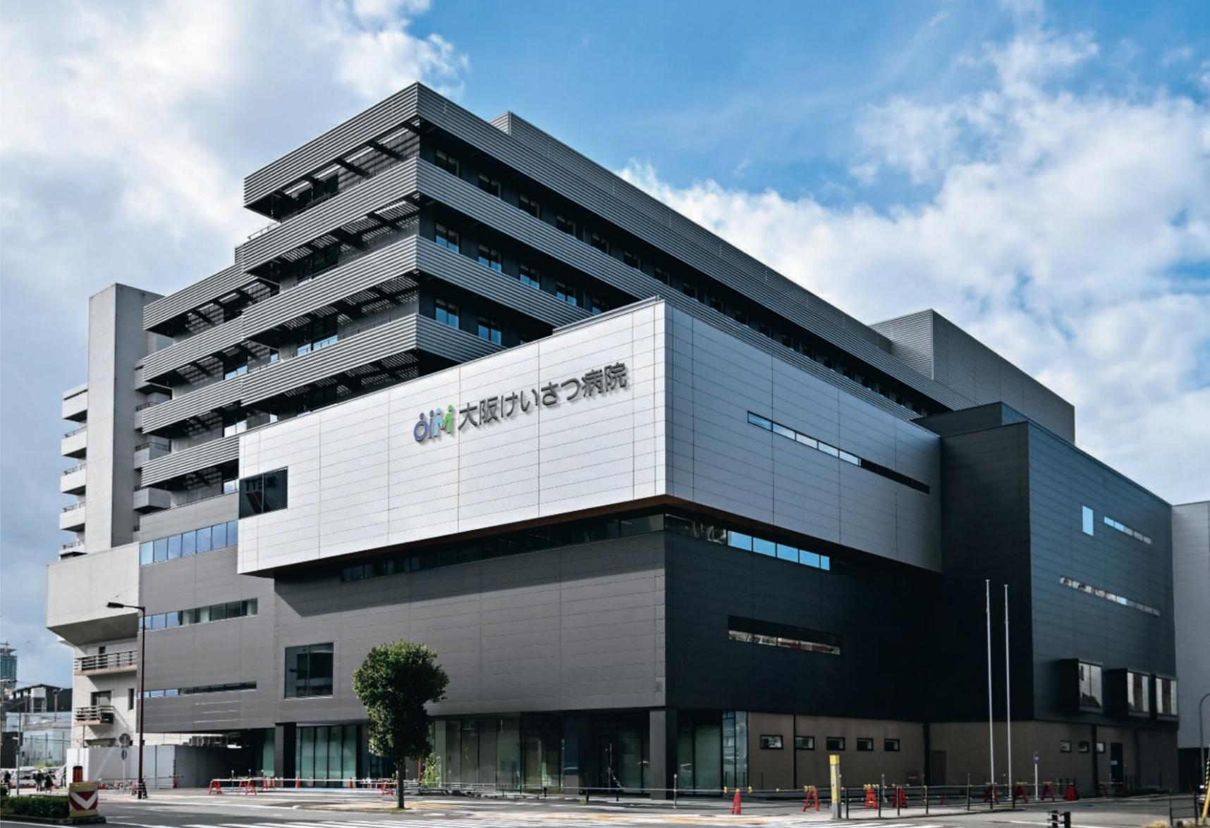
2025年1月に新築・オープンした大阪けいさい病院外観。敷地面積1万6696.79㎡、延床面積5万5593.83㎡、地上8階・地下1階、免震構造の建屋を持ち、病床数650床、集中治療室65床を設置するなど、最先端の医療を提供するための環境が整備されている。
